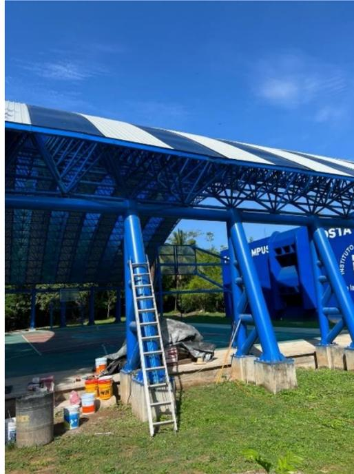
Imagen 52. Aplicación de pintura en estructura metálica
